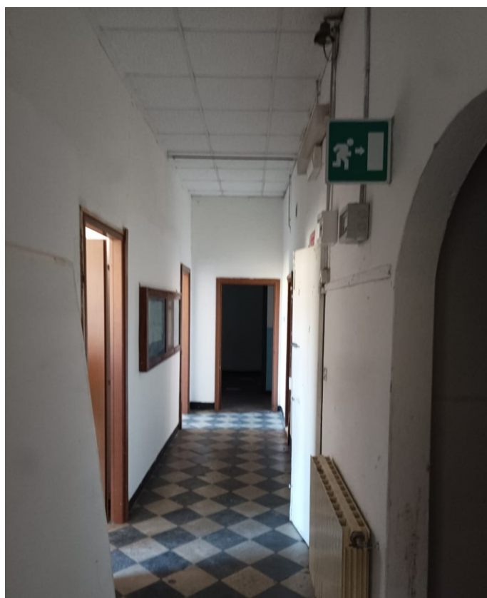
Fotografia 16: Interno – Piano primo
