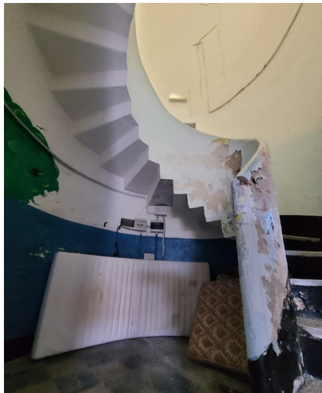
Fotografia 10: Interno – Scala interna
