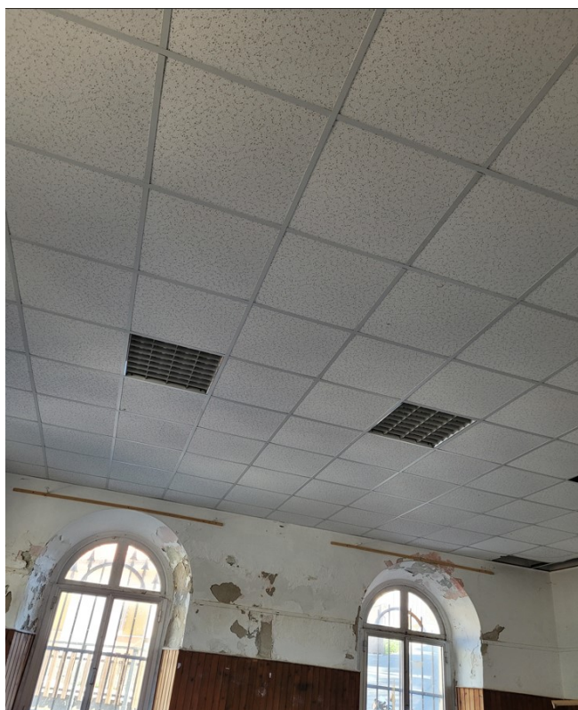
Fotografia 11: Interno – Controsoffitto piano terra
