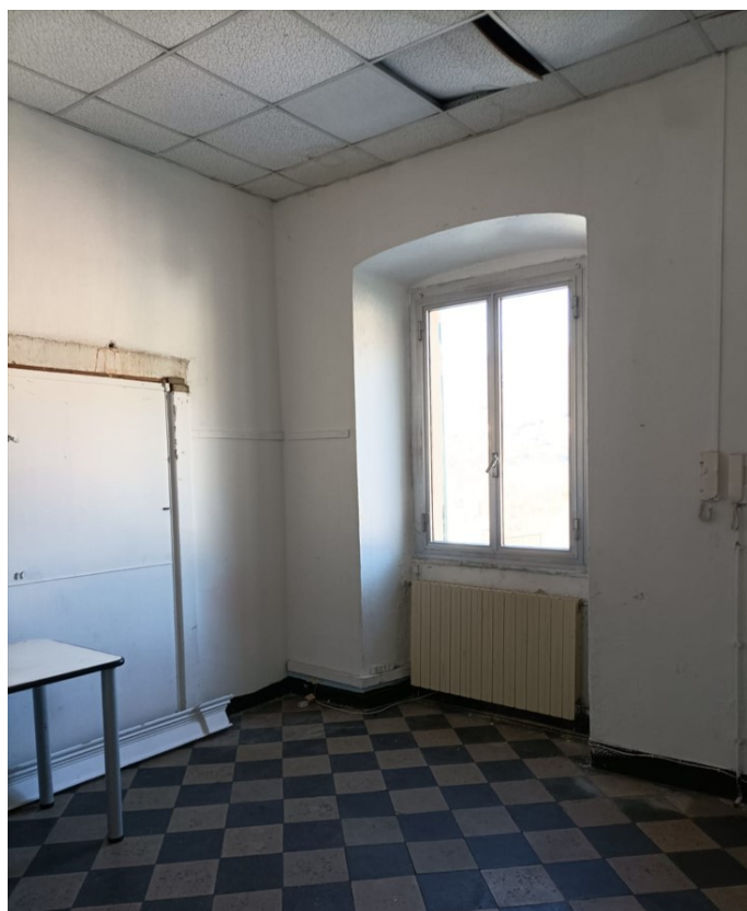
Fotografia 15: Interno – Aula piano primo
