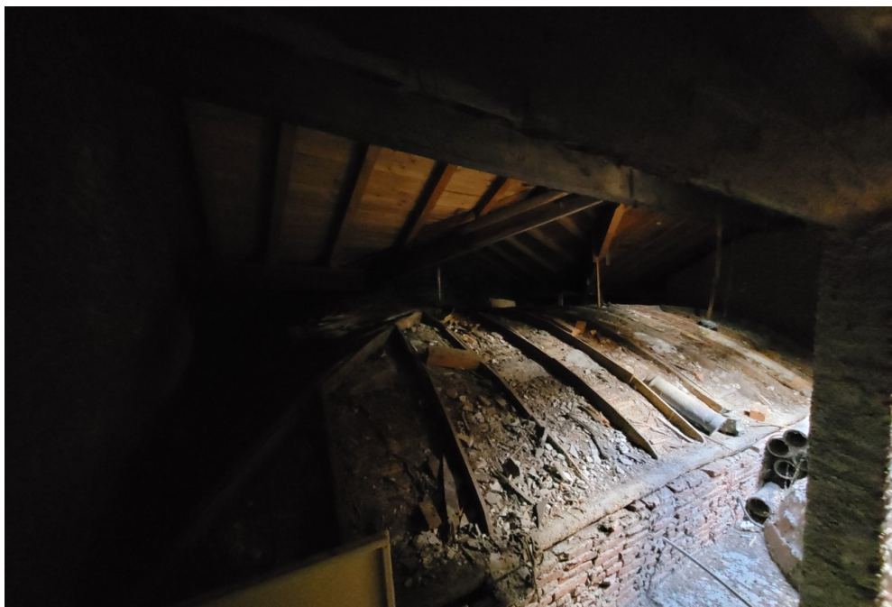
Fotografia 9: Interno – Estradosso della volta in canniccio posta a copertura dell'aula centrale del primo piano
