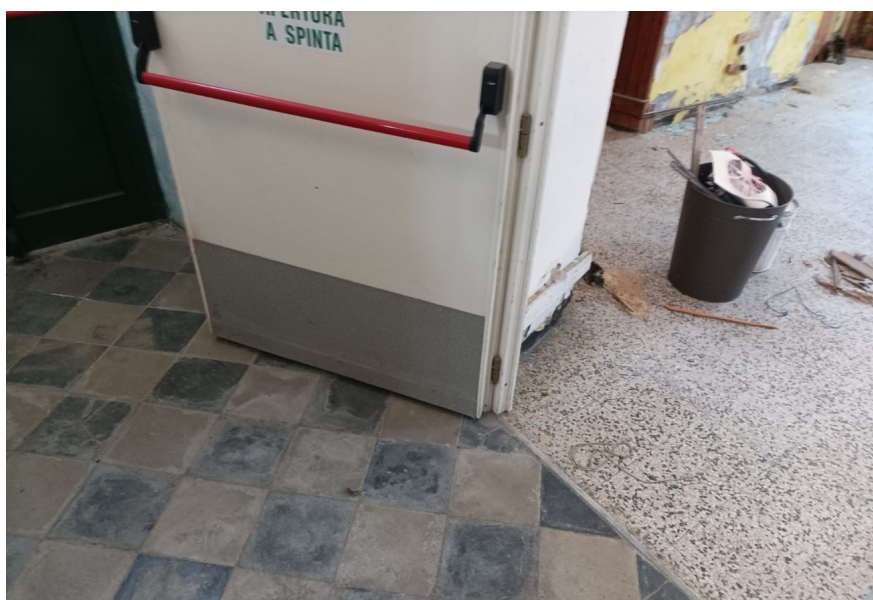
Fotografia 12: Interno – Pavimentazione interna piano terra
