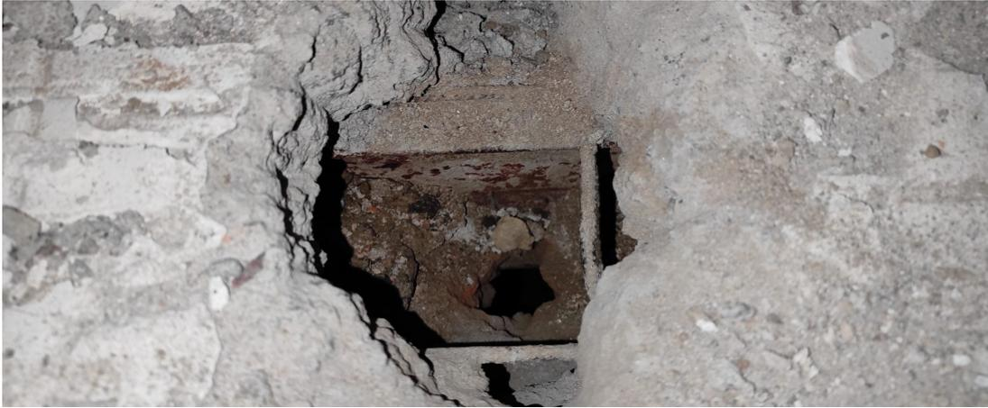
*Illustrazione 1: Saggio di indagine primo solaio corpo di fabbrica originale*
