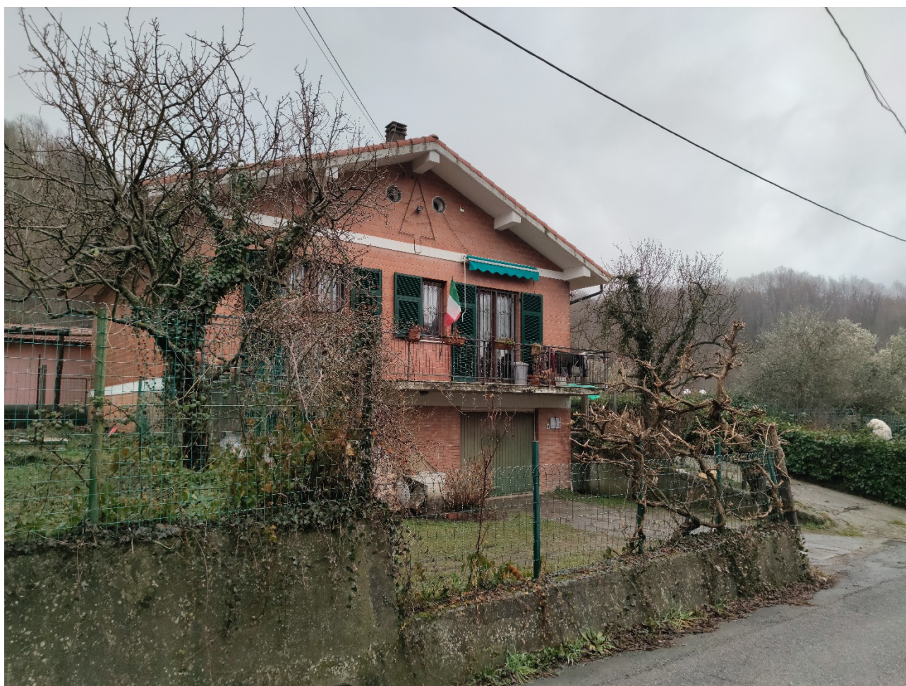
FOTO n.3 Vista del prospetto ovest (principale)
