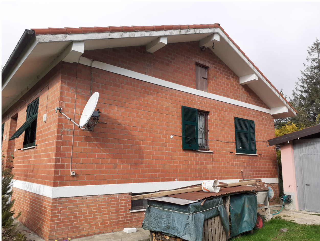
FOTO n.6 – Dettaglio retro fabbricato, prospetto est
