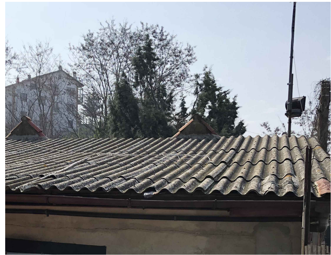
1 Vista faldia in eternit
