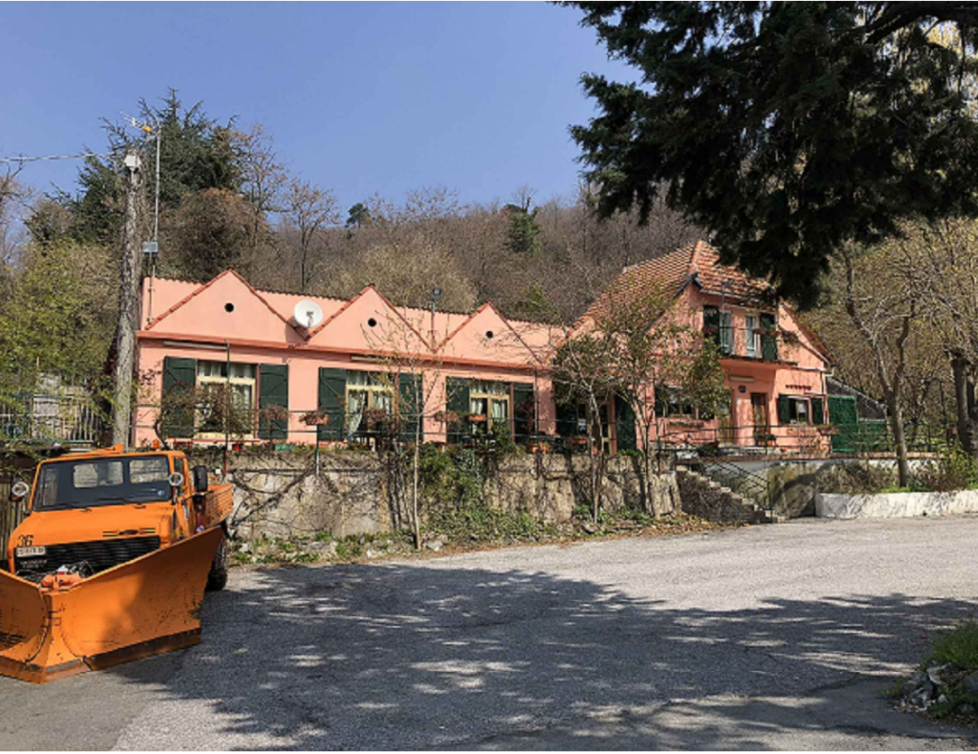
3 Vista intero fabbricato
