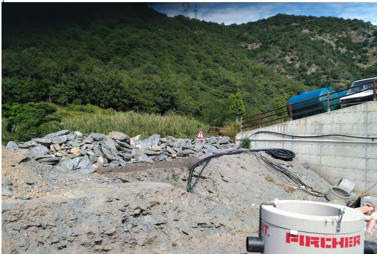
1 .Vista della posizione in cui verrà posizionato il raccordo di collegamento fra i due livelli di piazzale
