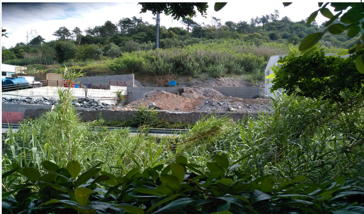
2.vista lungo la Strada Provinciale interessata dall' intervento della rampa
