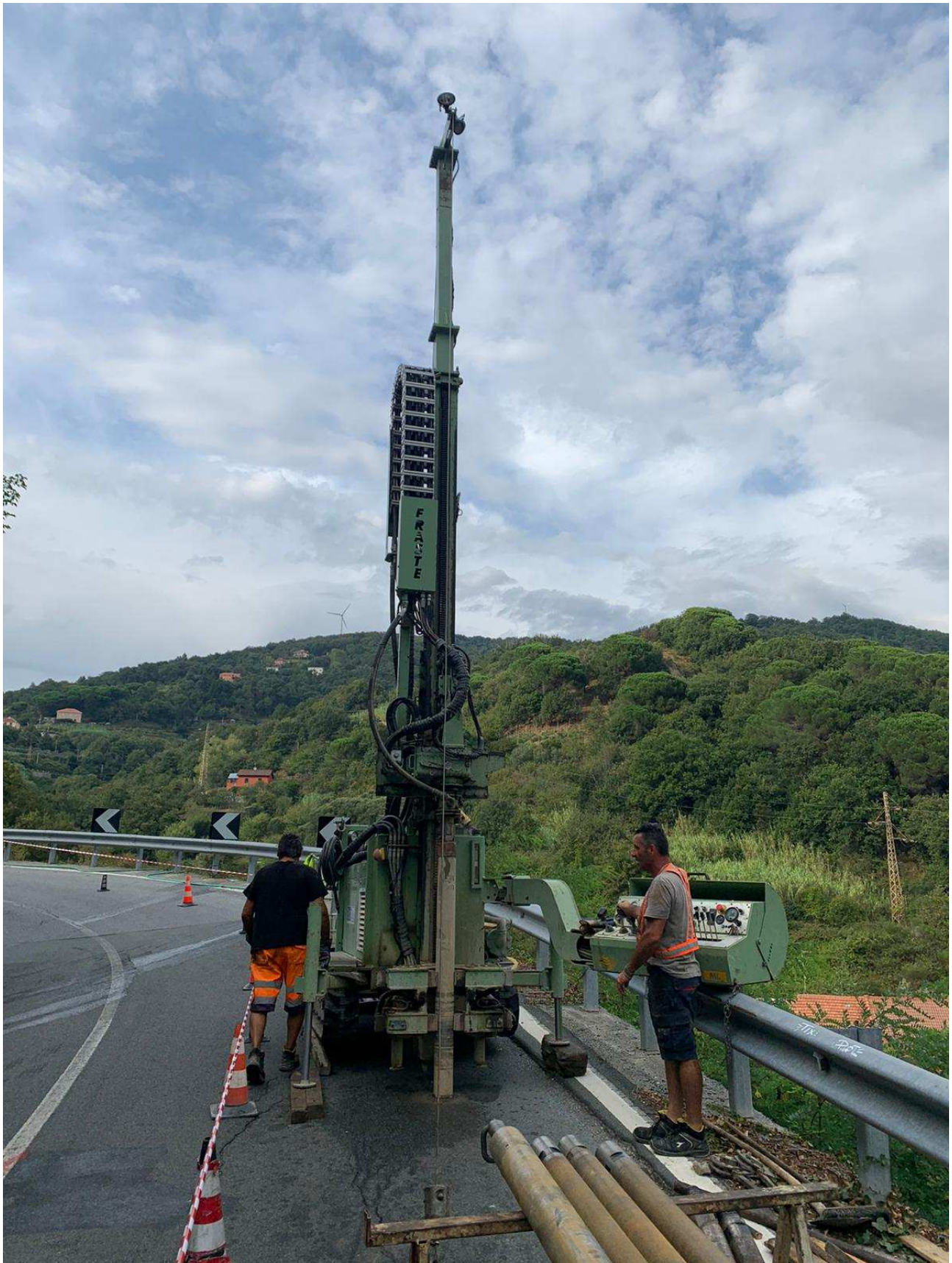
Figura 2.12: Esecuzione sondaggio S3 km 7+600
