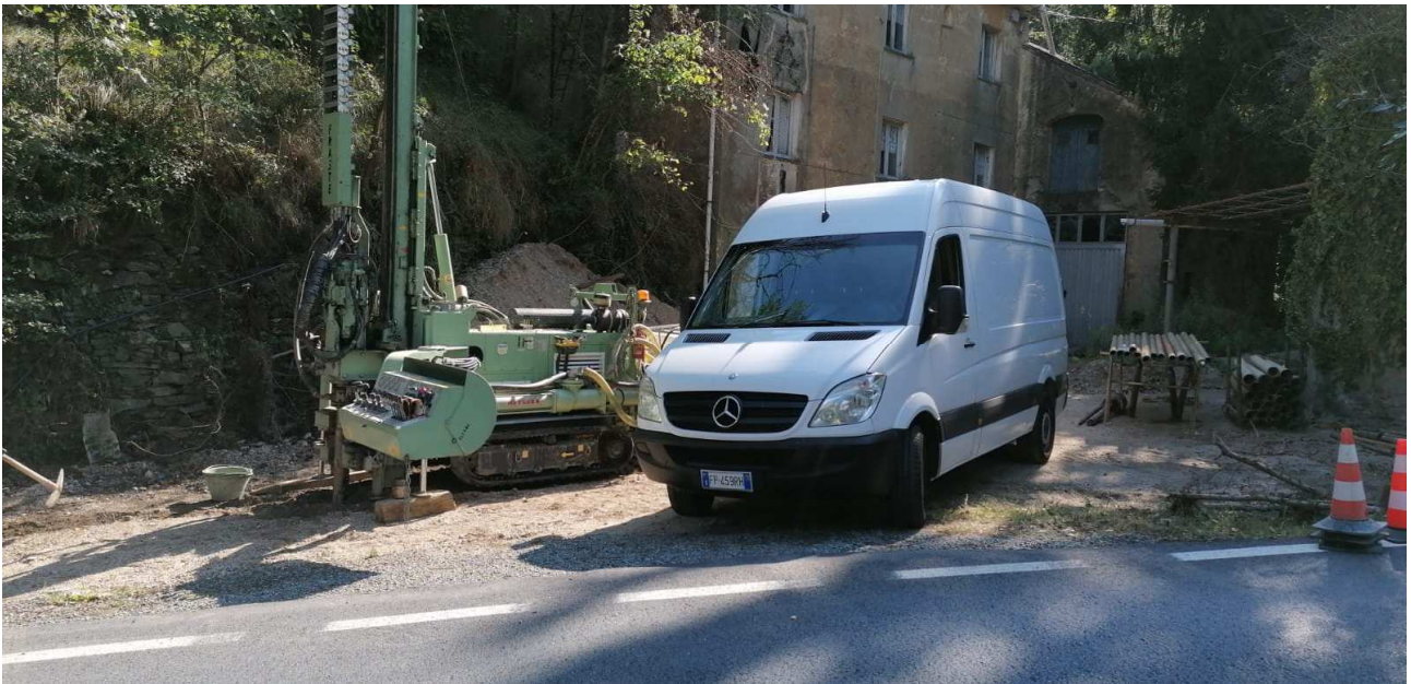
Figura 2.7: Esecuzione sondaggio S2 km 7+600
