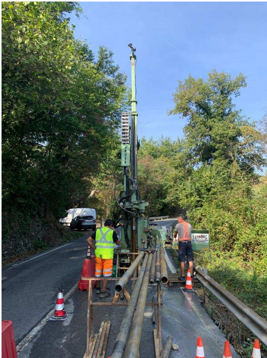
Figura 2.1: Esecuzione sondaggio S1 km 7+600
