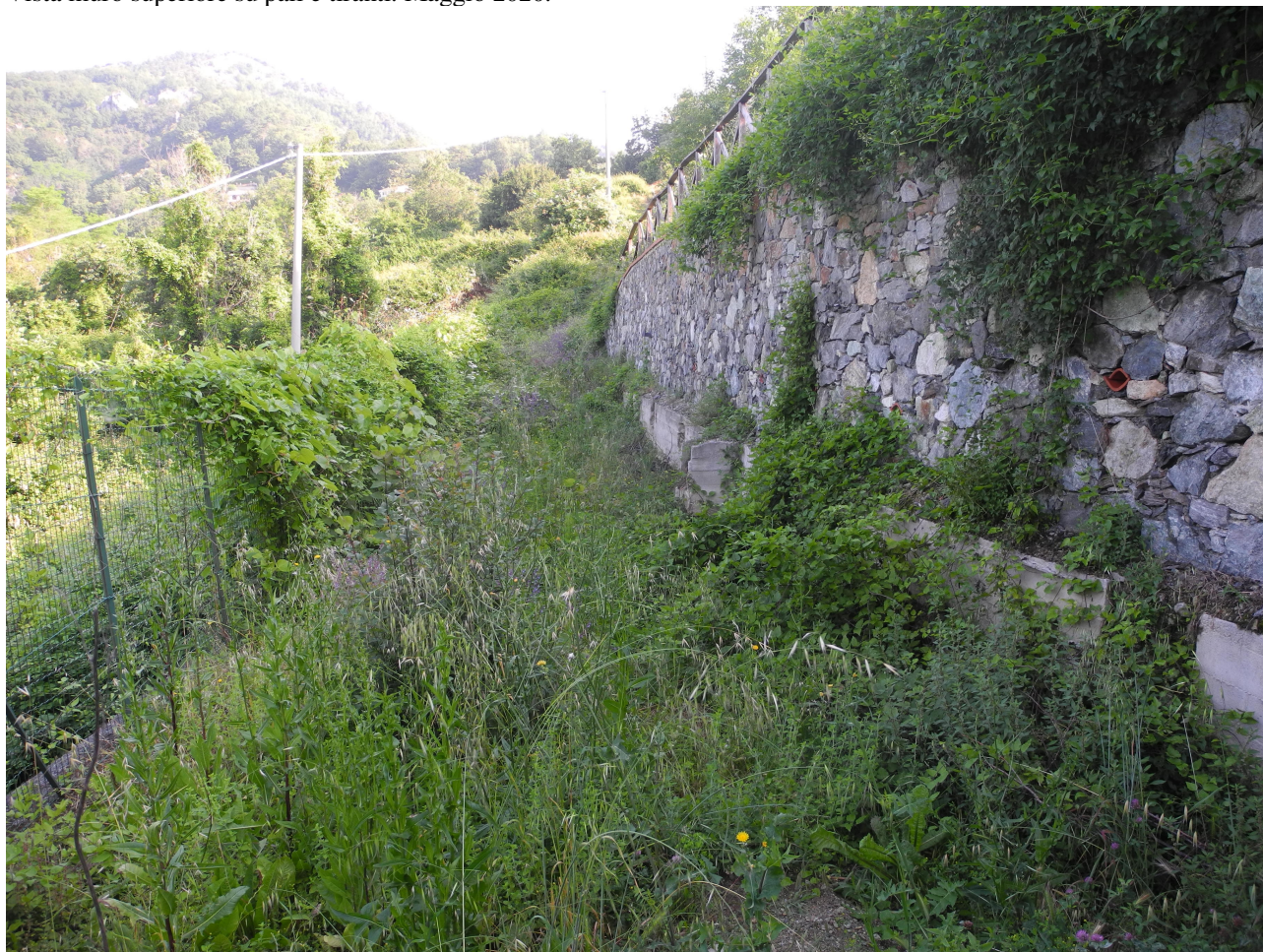
Vista muro superiore su pali e tiranti. Maggio 2020.
