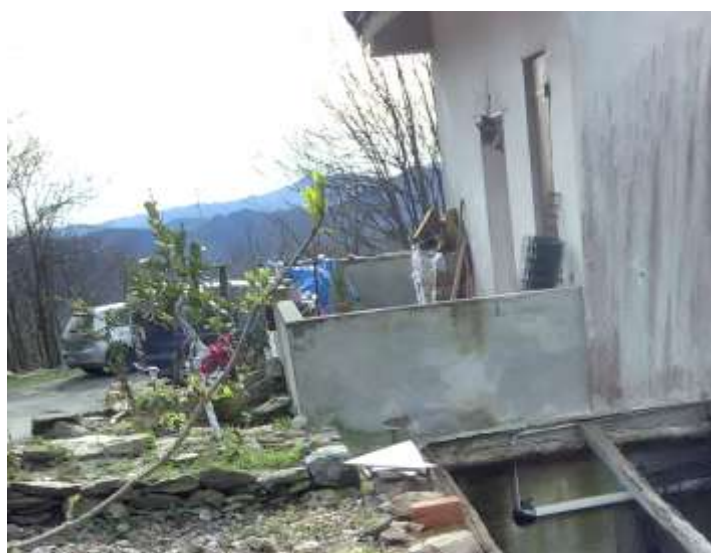
08_Facciata Est con balcone di ingresso
