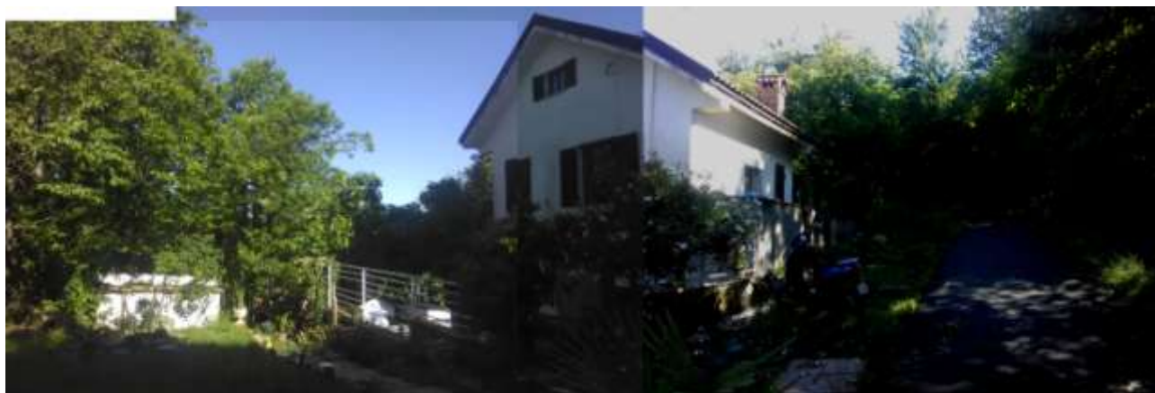
A_ collage di foto per realizzare vista panoramica della casa con il suo intorno. Fronte principale a sud. Foto scatta dalla strada privata ad uso pubblico di accesso all'abitazione
