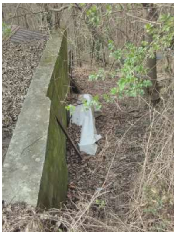
11_Scarpata a nord con il muro di contenimento
