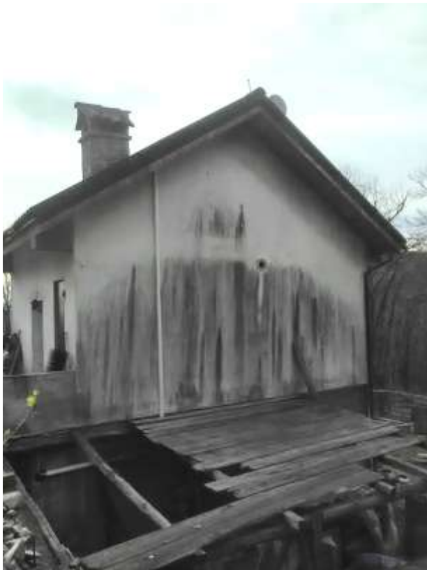
09_Facciata Nord vista dalla strada limitrofa
