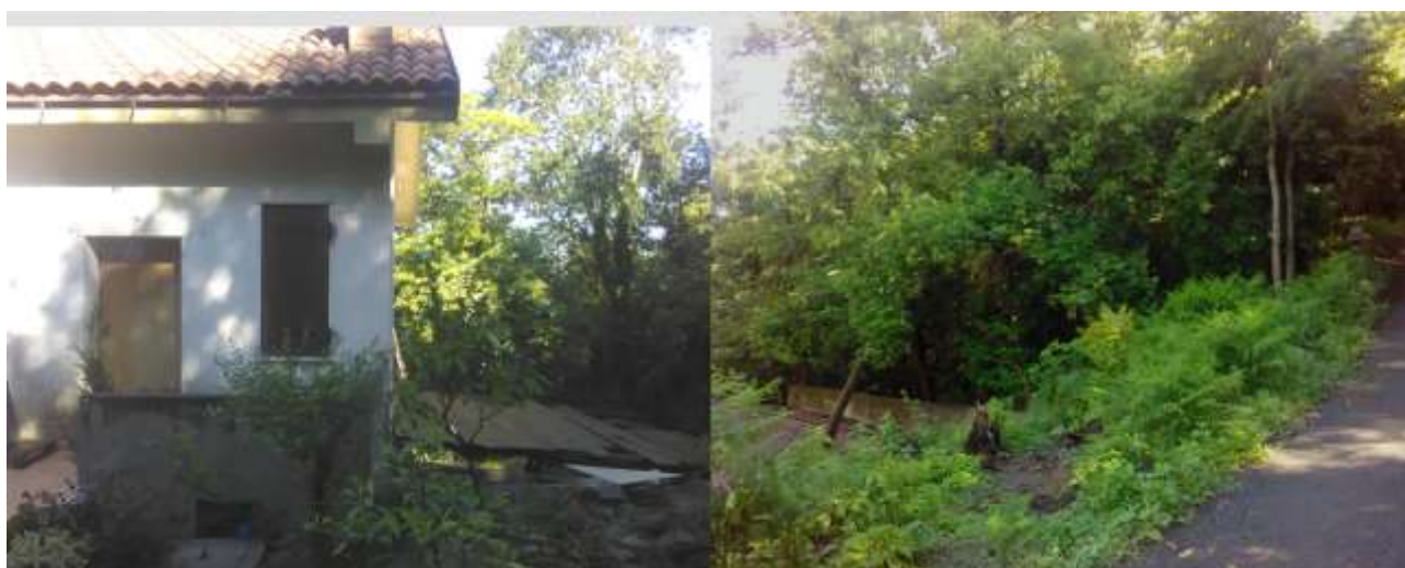
B_ collage di foto per realizzare vista panoramica della casa con il suo intorno. Lato Est con visione dell'area a nord di ampliamento. Foto scatta dalla strada privata ad uso pubblico di accesso all'abitazione
