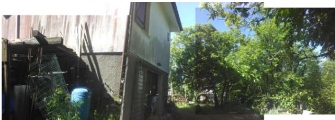
C_ collage di foto per realizzare vista panoramica della casa con il suo intorno. Lato Nord con visione della facciata Ovest che affaccia sul bosco antistante. Foto scatta dal piano giardino a quota ampliamento.
