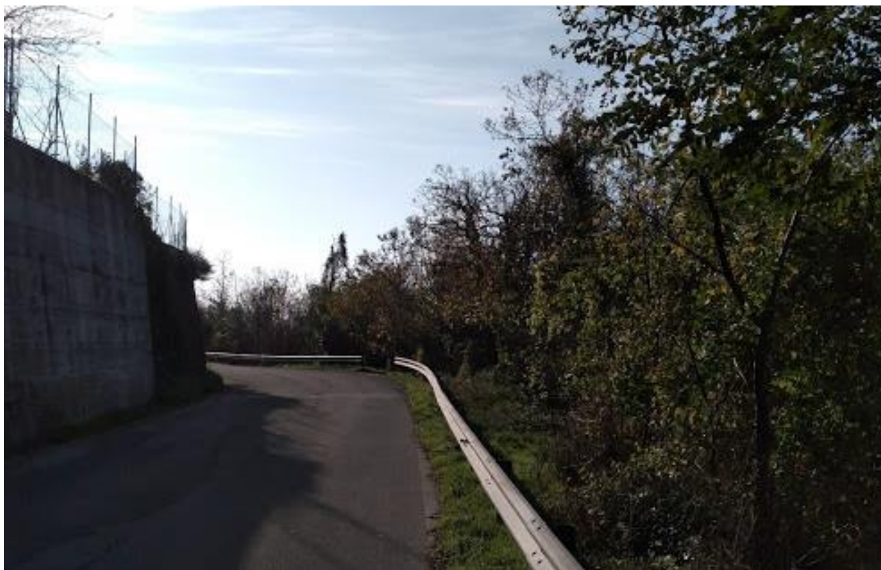
FOTO 1: vista della SP 542 da cui si imbocca la strada privata
