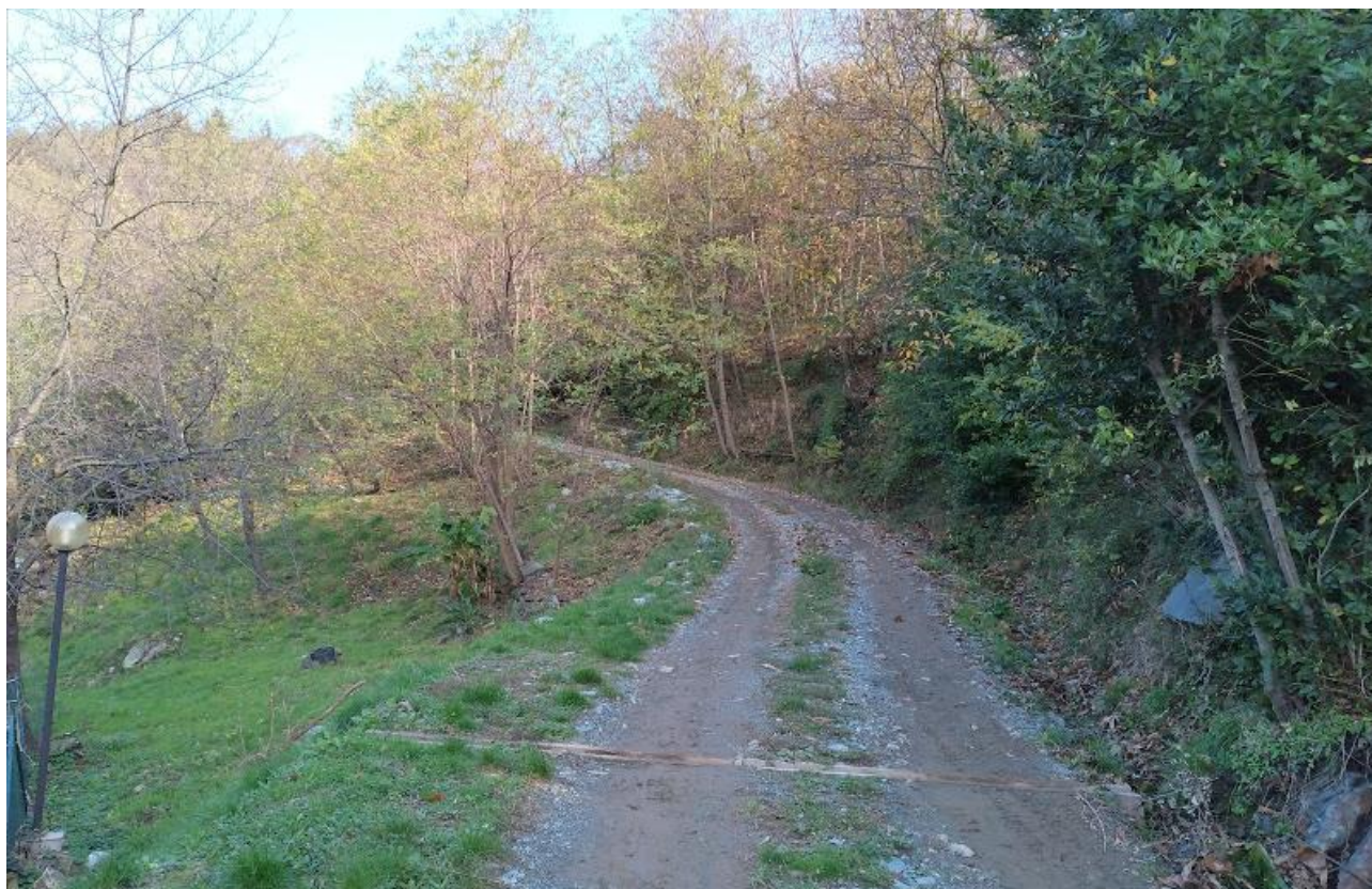
FOTO 8: vista dell'arrivo della strada
