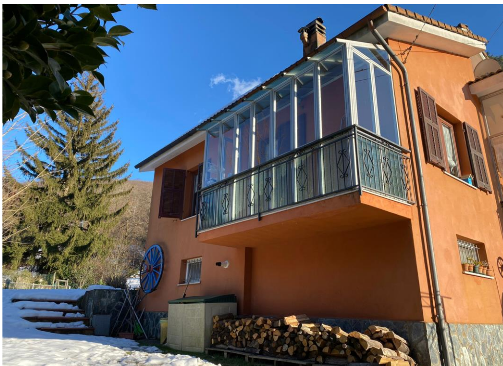
Foto 2 – Prospetto Nord – Ovest (Ante Operam)
