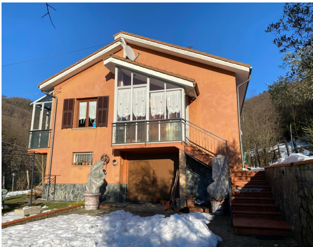
Foto 1 - Prospetto Sud - Ovest (Ante Operam)
