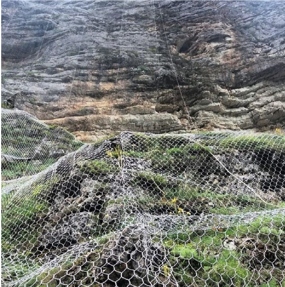
Figura 5: rete in aderenza a doppia torsione
