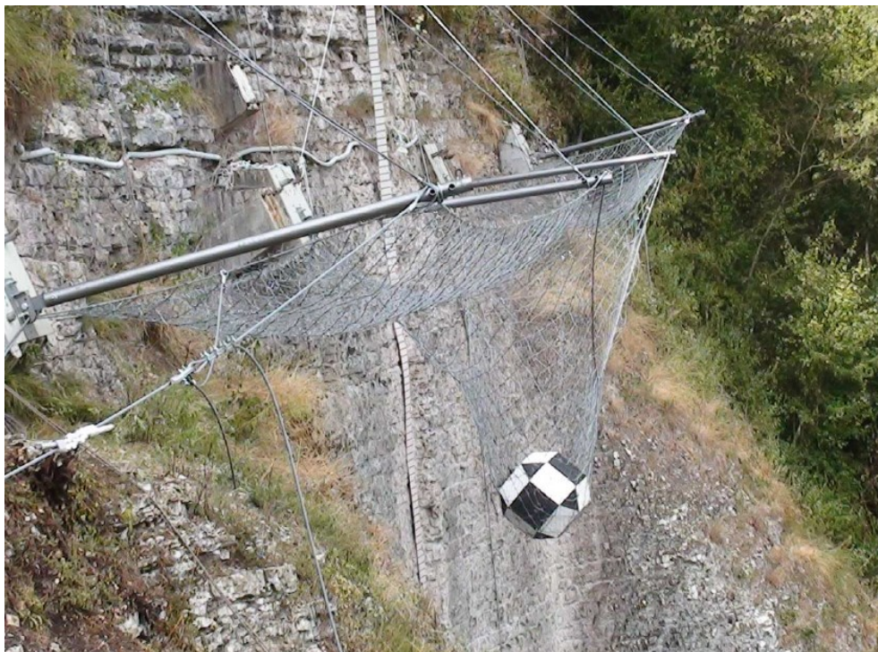
Figura 4: barriera paramassi – test in vera grandezza
