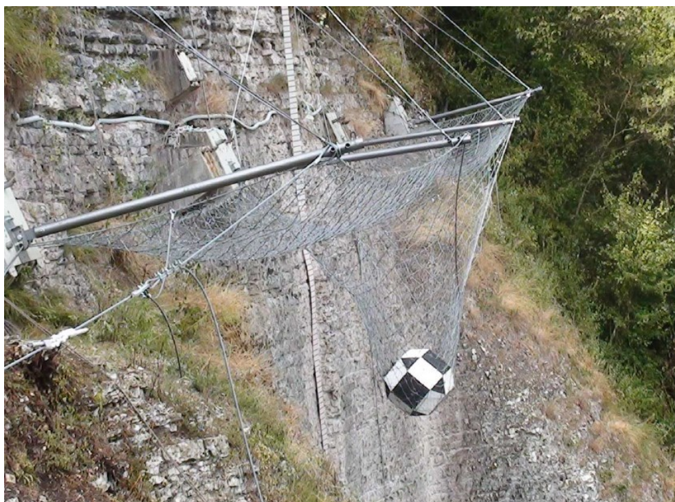
Figura 1: barriera paramassi – test in vera grandezza
