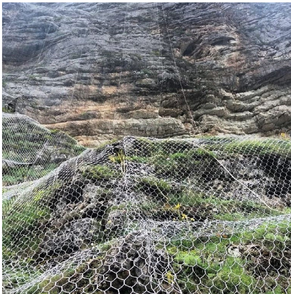
Figura 5: rete in aderenza a doppia torsione
