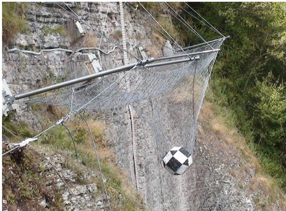
Figura 4: barriera paramassi – test in vera grandezza
