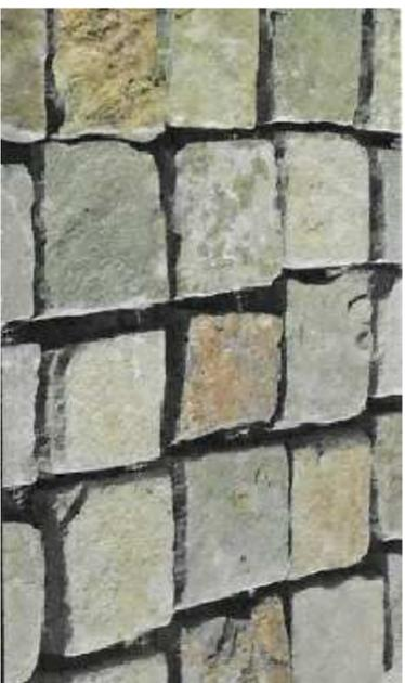
PARTICOLARE DELLA PAVIMENTAZIONE POSATA A SECCO
