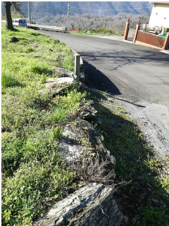
**Figura 8: Scogliera esistente realizzata al termine del muro esistente nella porzione sud. In corrispondenza si nota il termine dell'asfalto di nuova realizzazione**
