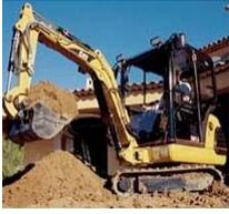
Rinterro di scavi con materiale proveniente dallo scavo e depositato in cantiere, compresi il carico, il trasporto, lo scarico e lo stendimento, nonché l'onere per il costipamento del materiale di rinterro o riporto, eseguito con mezzi meccanici.
