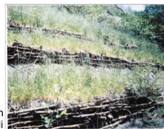
Alcuni ordini di graticciate con inerbimento di specie locali
