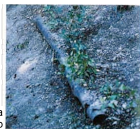
Un tratto di palizzata semplice di circa 3,5 ml con le piantine a lavoro ultimato
