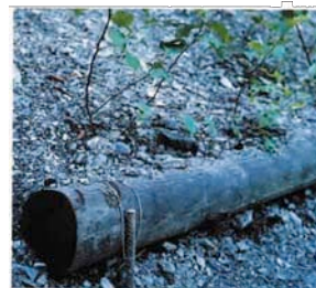
Un tratto di palizzata semplice di circa 3,5 ml con le piantine a lavoro ultimato
