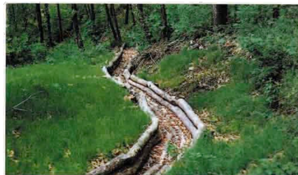
CANALE PER CONVOGLIAMENTO ACQUE a monte di una sistemazione di versante realizzato con tondame di castagno ricavato dal diradamento dei bodchi contigui
