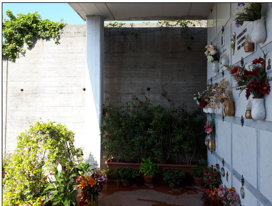
Particolare del tratto di muro di contenimento in cui verrà realizzata l'apertura per la creazione del collegamento tramite scala
