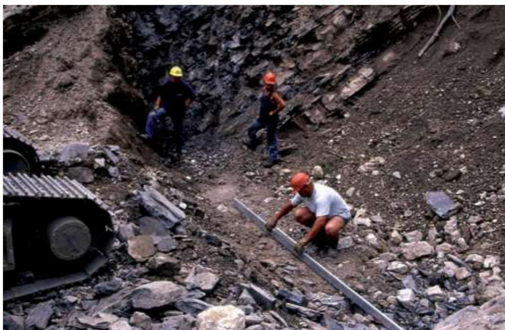
*Briglia viva in legname e pietrame. Predisposizione della sede di posa: controllo delle caratteristiche del piano di appoggio basale (in opera) (Foto R.Ferrari).*
