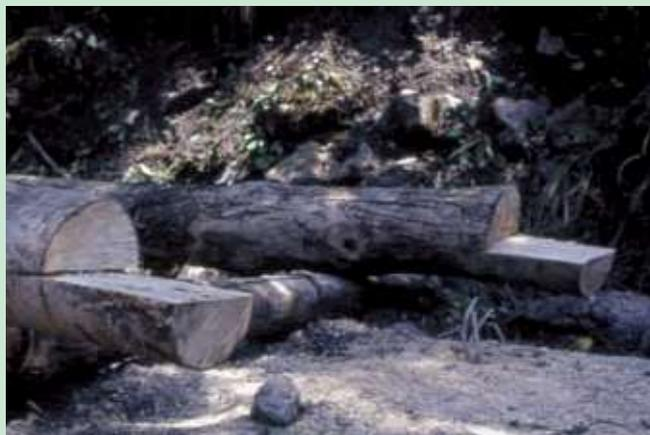
5) Ripetere l'operazione di taglio sul secondo elemento, dopo averlo ruotato di 180°.
