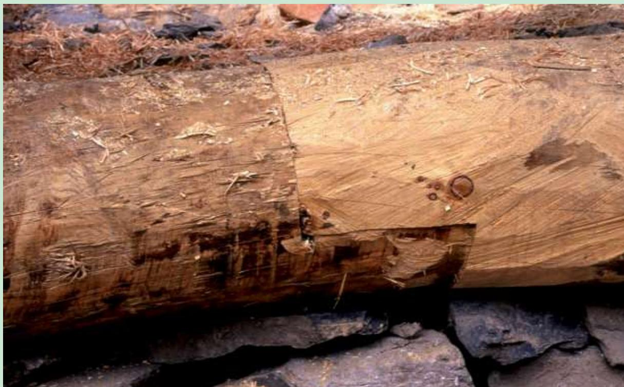
*Unione di due tronchi contigui mediante incastro a sormonto e chiodatura (Foto R.Ferrari).*
