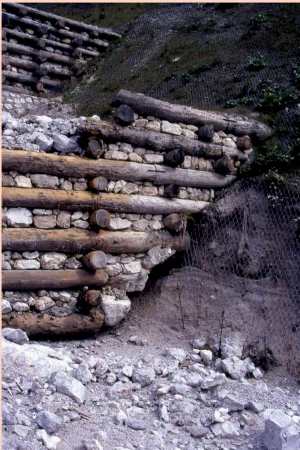
Briglia viva in legname e pietrame. Erosione e scalzamento al piede per insufficiente ammorsamento laterale; totale assenza di materiale vegetale vivo, senza possibilità di inserimento successivo: non può essere considerata un'opera di Ingegneria Naturalistica (post operam) (Foto R. Ferrari).
