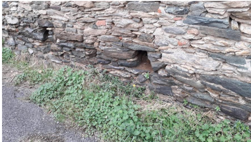
Foto 4 Dettaglio muro da smontare e ricostruire
