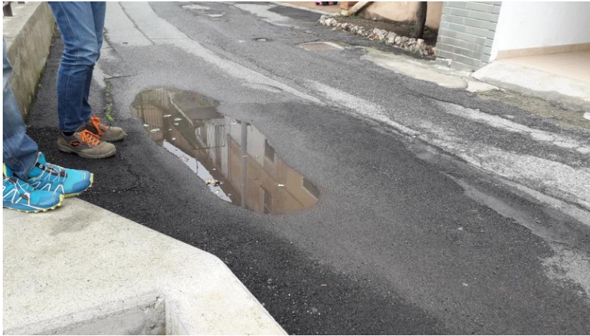
Foto 5 Porzione di via alla Fontana oggetto di intervento
