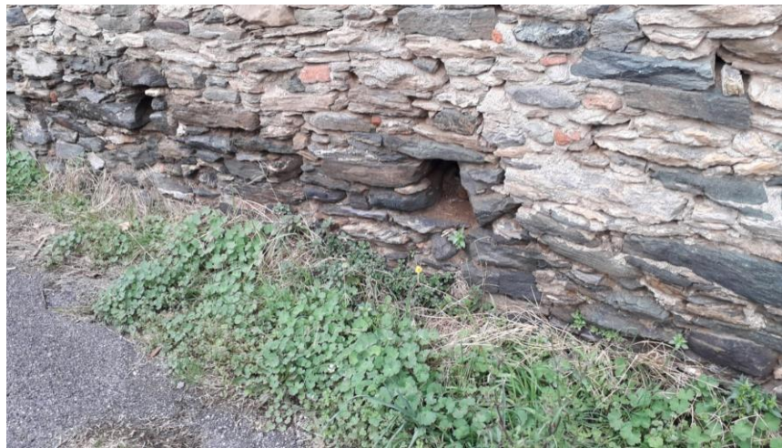
Foto 6 Dettaglio muro da smontare e ricostruire
