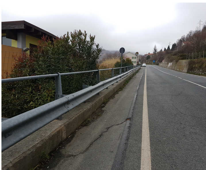
Illustrazione 1: S.P.334 a monte della strada
