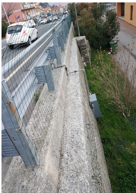
Illustrazione 2: muro di sostegno al bordo della S.P.334
