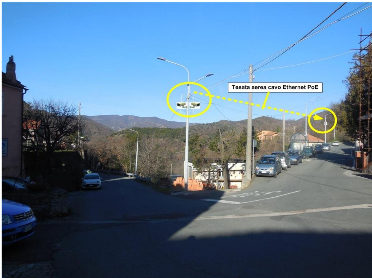
Le due telecamere saranno collegate con una tesata aerea di un cavo ethernet PoE verso una secondo palo di illuminazione pubblica<sup>1</sup> il quale, a sua volta, trasmetterà i segnali, sempre con un link wireless PtP, verso il ripetitore RAI di seguito illustrato.
