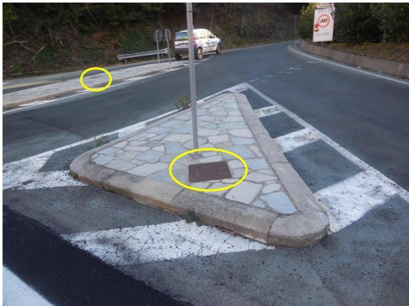
Dovrà invece essere realizzato uno scavo di attraversamento stradale tra l'aiuola spartitraffico intermedia, con rimozione parziale e successivo ripristino della pavimentazione dell'aiuola intermedia, ed il contatore:
